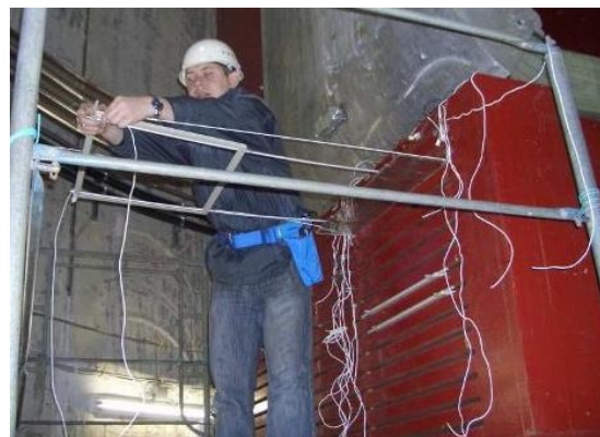
Testowanie metody instalacji modułów w Krakowie i rzeczywista instalacja w J-PARC
